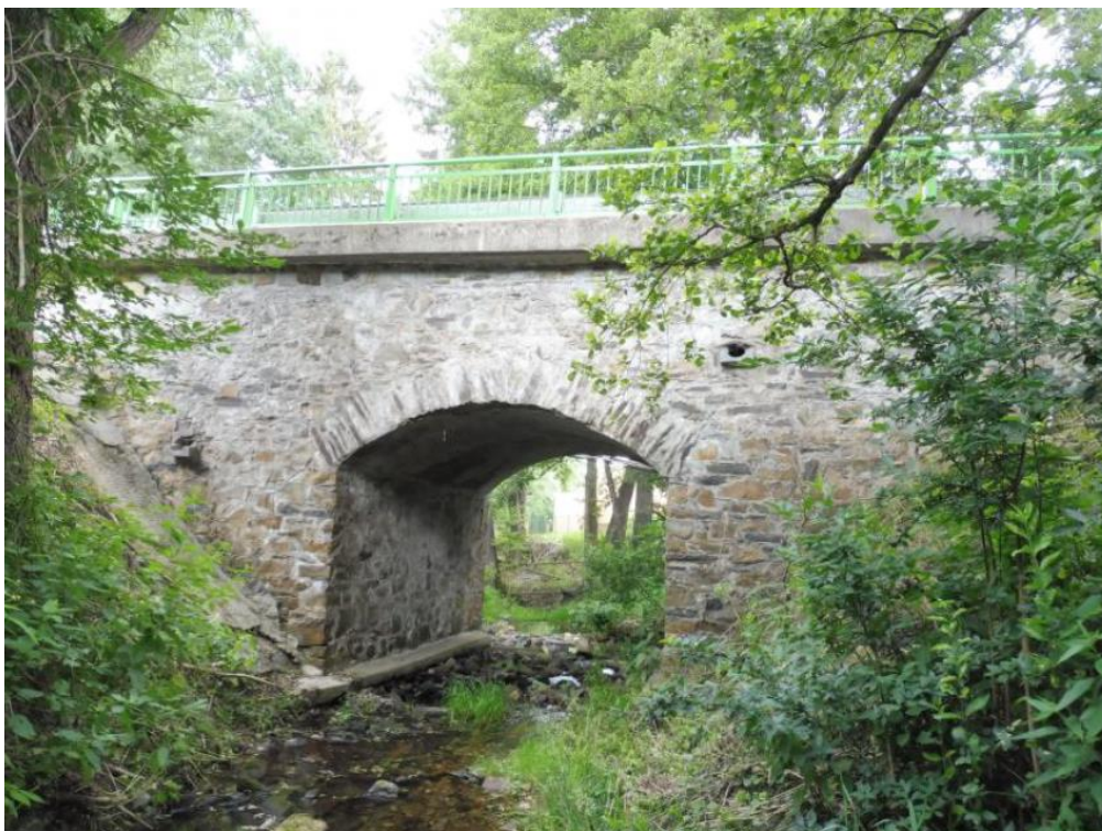
Obrázek 2 Boční pohled na celý most z pravé strany ve směru staničení
