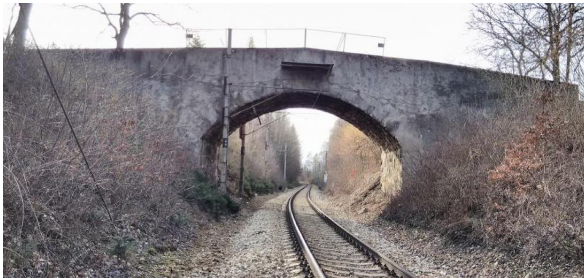
Obrázek 2 Boční pohled na celý most z levé strany ve směru staničení
